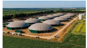
Biovéa 46 MW Biomass Côte d'Ivoire
